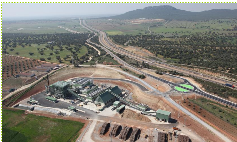
Figura 2: Planta de biomasa perteneciente a ENCE ENERGÍA EXTREMEÑA, S.L. con una potencia térmica de 71,15 MW, diseñada para la generación de 20 MW de electricidad mediante el procesamiento de astillas de cultivo energético y restos forestales.
