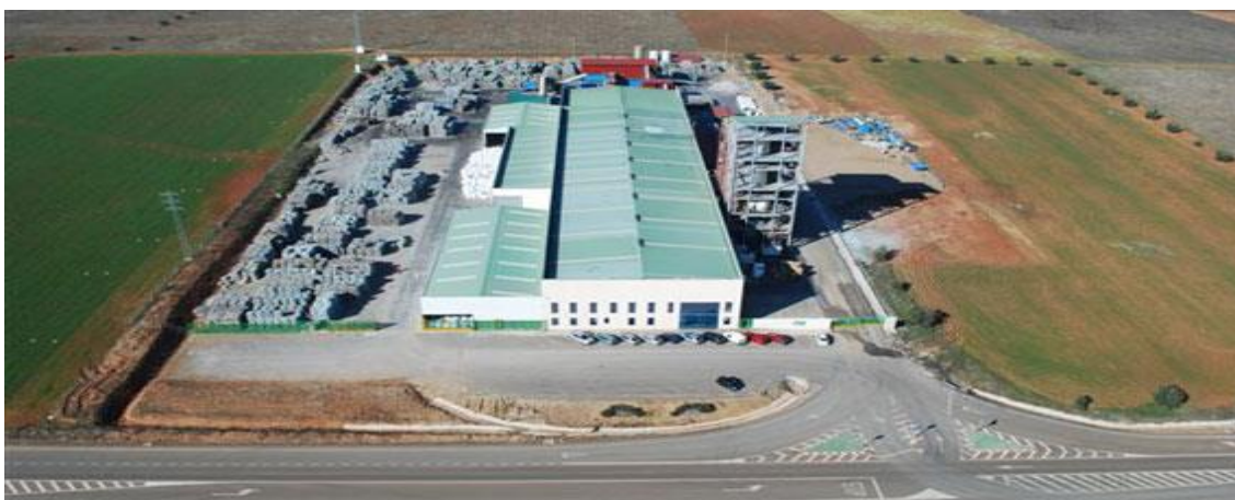
Figura 1: Planta de reciclaje de plástico PET ubicada en Torremejía (Badajoz)
